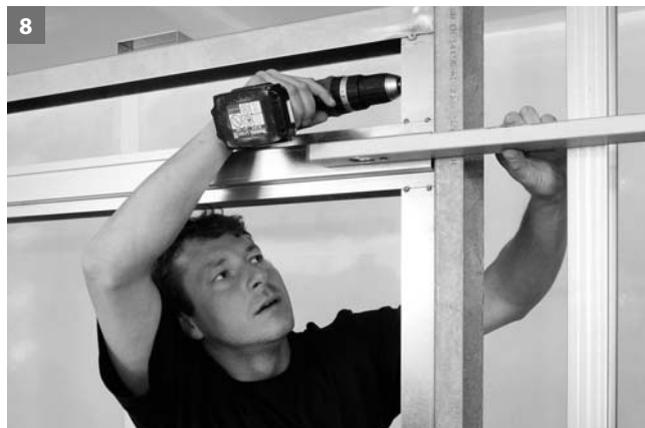
8 Zarge mit der Wand fluchtend ausrichten und zuerst oben an UA-Profil mit mind. 3 x 2 Stck. Blechschrauben anschrauben. Kontrolle mit Wasserwaage.
