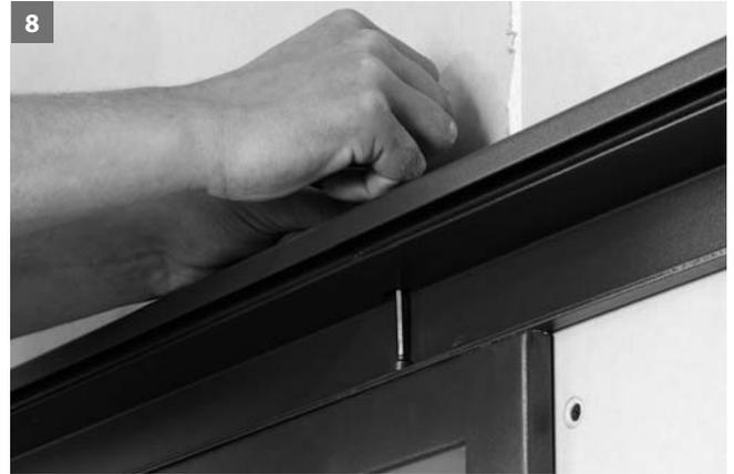
8 Mit Inbusschlüssel an Zarge verschrauben.
