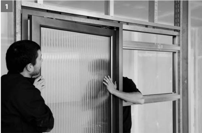
1 Die Schiebetür wird in die Schiebetürzarge eingefädelt.
