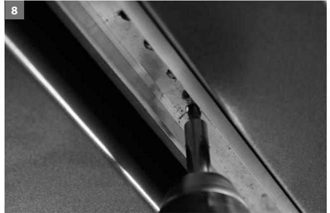
8 Anschließend Laufschiene mit Schraube in Verbohrung nach oben sichern.
