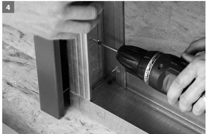
Die Ständerwand muss die Montage an UA-Aussteifungsprofilen erfolgen
