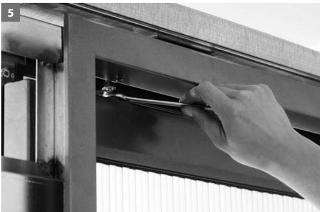
5 Klemmung des Türblattes vornehmen und mit Mutter fixieren. (mit Gabelschlüssel SW13)
