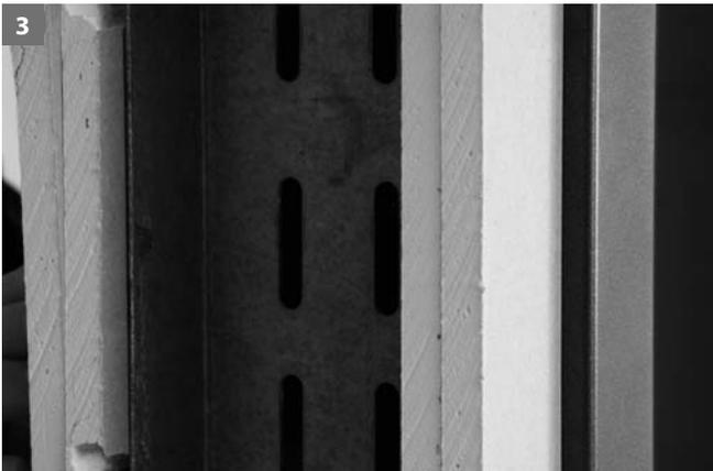
3 Auf beiden Seiten mit Wasserwaage ausrichten...
