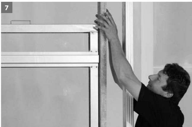
7 UA-Profil lotrecht an Mauerkasten anstellen und am Boden und Decke befestigen
