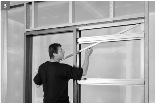
3 Einfädeln der Laufschiene in Mauerkasten.
