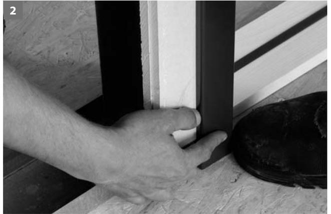
2 Bei Umfassungszargen Beplankungstärke mit Streifen der Gipskartonplatte einrichten.
