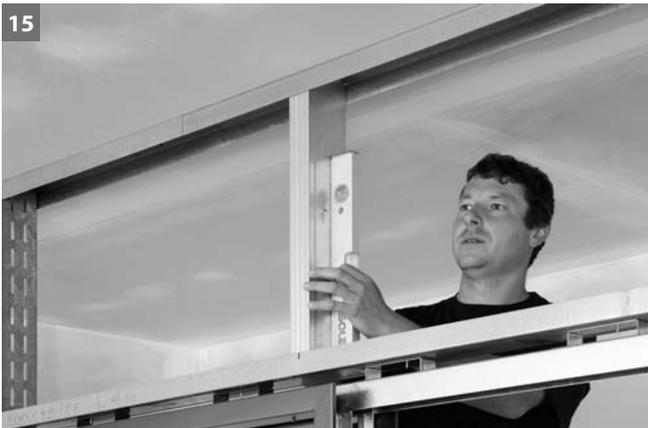
15 CW-Profil nach oben abhängen, um die Zarge zu entlasten.
