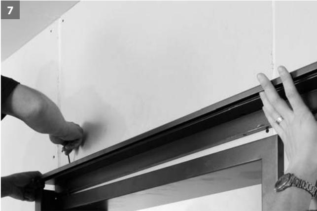
7 Schrauben lösen. Laufschienenträgerprofil auf Zargenkopfteil positionieren.
