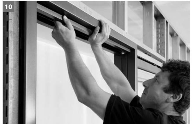
10 Die Abdeckung kann nach Einhängen des Türblattes mit einem festen Druck aufgeklipst und ohne Werkzeug wieder entfernt werden.
