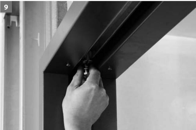
9 Einschieben der Laufwagen und Anschlag montieren.
