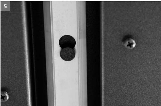
5 Kontrolle ob Laufschiene Richtig in Aufnahme eingerastet.
