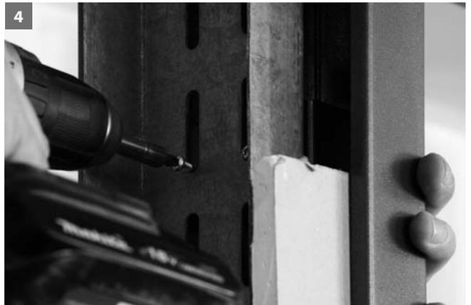
4 ...und anschrauben. Mit geeignetem Schraubmaterial (Blechschaube mind. Gr. 4,8) UA-Profil mit den Laschen an der Zarge mit mind. je 2 Schrauben per Lasche verschrauben.
