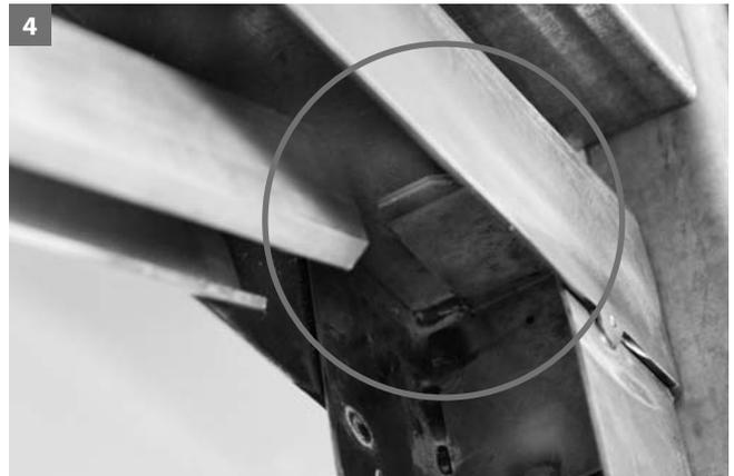
4 Laufschiene im Mauerkasten in die Nase einstecken und nach oben durch die Aufnahmebolzen drücken.
