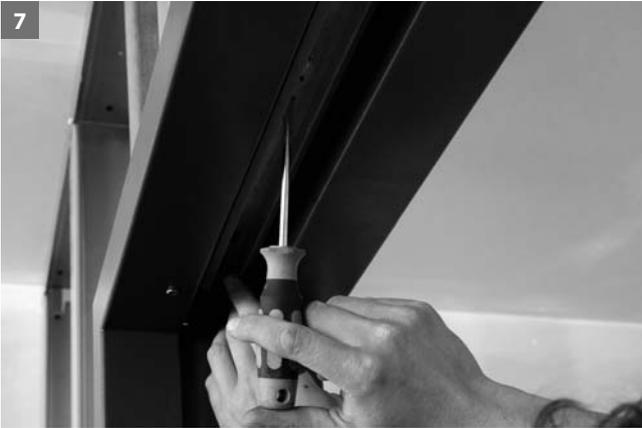
7 Mit Schraubendreher in Verbohrungen der Laufschiene einhaken und die Laufschiene bis Anschlag Richtung Einlaufkasten zurückschieben.
