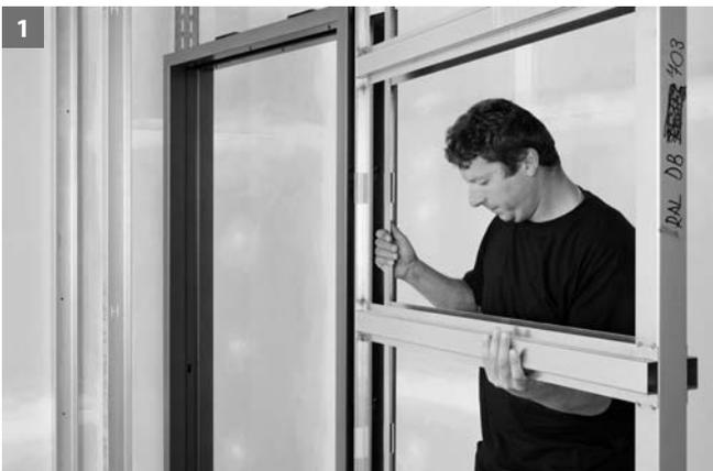
1 Maueröffnung entsprechend dem Außenmaß der Zarge herstellen. Das Ziegelmauerwerk muss mit einem Überlager ausgestattet sein. Die Zarge darf keine Kräfte des Mauerwerks aufnehmen. Mauerkasten mit Putzträgerplatten in die Zarge einhängen.
