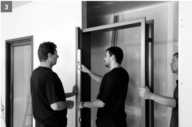
Anschließend wird die Zarge in die Wandöffnung eingebracht, ausgerichtet und dem Wandaufbau entsprechend fachgerecht montiert und verankert.
