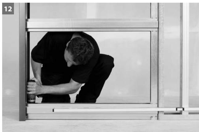
12 Kontrolle der Flucht von Zarge und Mauerkasten, ausrichten und auf Fußboden bzw. mit UA-Profil verschrauben.
