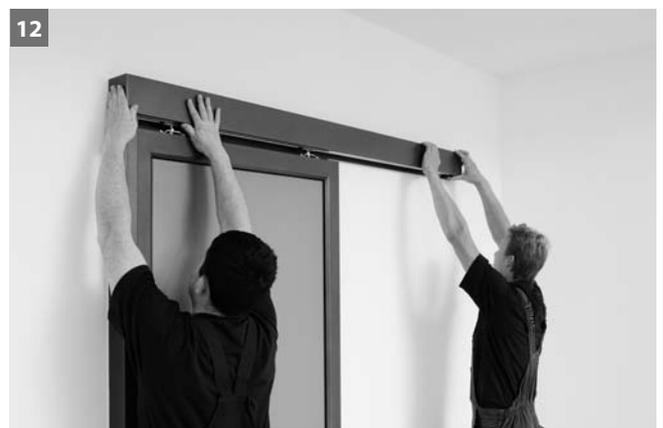
12 Nach der Türblattmontage (Kapitel 7) wird die Abdeckung auf Laufschiene aufgesteckt.
