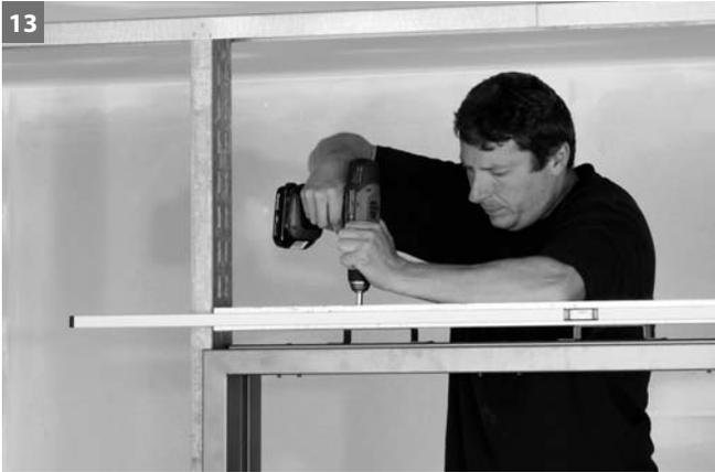
13 Nach Ausrichten den Querteil mit CW-Profil versteifen. Mit mind. 2 Schrauben per Lasche, sowie CW-Profil am UA-Profil anschrauben
