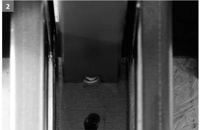
2 Bei der innenliegenden Zarge muss das Türblatt über den Bodenführungsbolzen geführt werden.
