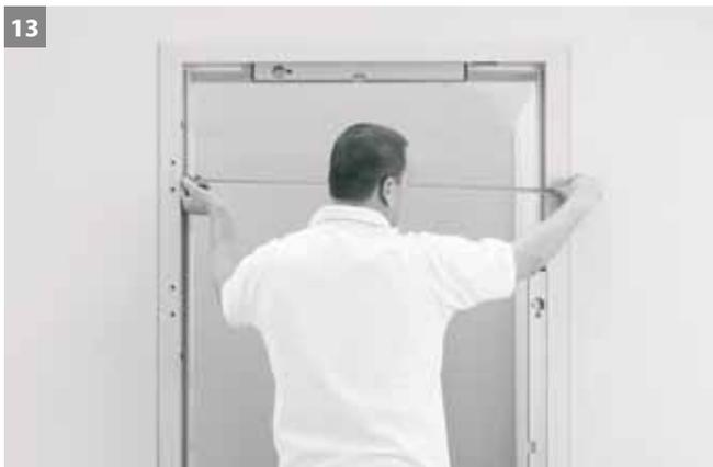
13 Durchgangslichten im oberen, mittleren und unteren Bereich der Zarge messen und ausrichten.
