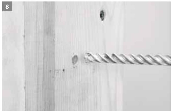
Das Mauerwerk durch bestehende Löcher der Leibung mit Steinbohrer (Ø 10mm) aufbohren (Bohrungstiefe gesamt ca. 10 cm).
