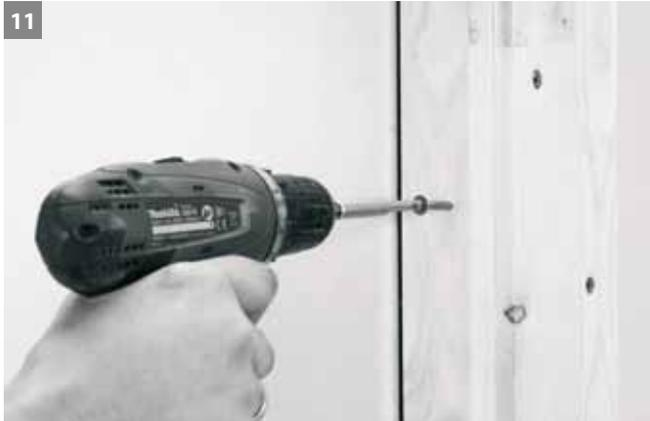
11 Spiegel des Holztürstocks mindestens 5 Mal falzseitig auf Schloss- und Bandseite mit Holzschrauben (zB.: Ø 4,5x50 mm) verschrauben (beginnend 10 cm über OFF, über Türstockhöhe gleichermaßen aufgeteilt).
