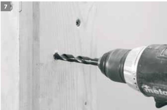
Bohrungen aus Schritt 4 mit einem Holz- bzw. Stahlbohrer (Ø 10mm) bis zum Mauerwerk bzw. Mörtel aufbohren.
