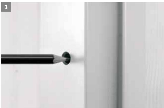
Den bestehenden Holztürstock bzw. die Stahlzarge durch die Zargenbandstanzung mit einem Stift markieren.
