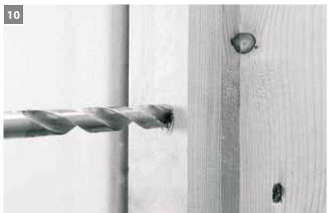
Markierung von Schritt 3 mit Bohrer (Ø 13mm) mindestens 10 mm tief aufbohren.
