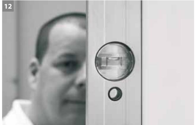
12 Zarge wieder in die Öffnung stellen und Spiegel bzw. Leibung mit einer Wasserwaage ausrichten.
