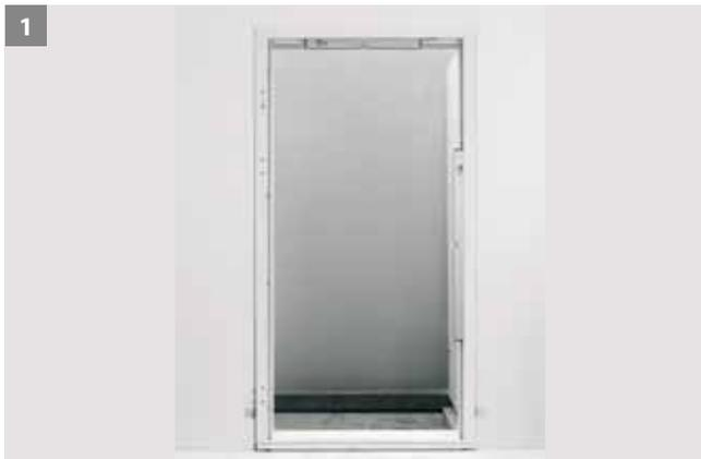
Zarge in Öffnung stellen und mit einer Wasserwaage laut Bild 12, 13 und 14 ausrichten.
