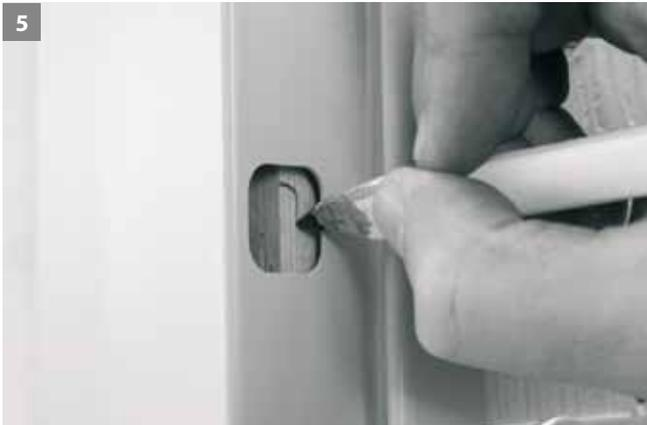
Bestehenden Holztürstock bzw. Zarge im Bereich der Sicherungszapfen und Schlosstanzen für darauf folgenden Arbeitsschritt anzeichnen. Zarge wieder aus der Öffnung nehmen.
