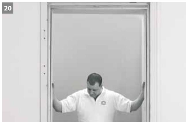
20 Leibung des zweiten Zargenteils auf der Gegenseite der bereits eingebauten Zarge zwischen Leibung und Dübelanker einstecken. Anschließend Dichtung laut beiliegender Dichtungseinbauanleitung einlegen.
