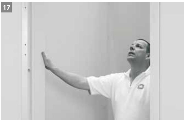
17 Leibung des zweiten Zargenteils auf der Gegenseite der bereits eingebauten Zarge zwischen Leibung und Dübelanker einstecken und anschließend kontrollieren.
