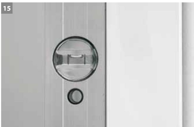
15 Ausrichtung der Zarge abschließend überprüfen und bei Bedarf nachrichten.
