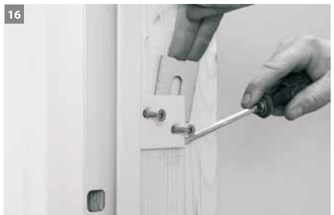
16 Senkkopfholzschrauben (zB.: Ø 6 x 70 mm) in die von Schritt 9 eingefügten Dübel bis zur Hälfte eindrehen. Spalt zwischen Dübelanker und bestehender Stockleibung mit Distanzplättchen hinterfütern. Zargenmaße kontrollieren und festschrauben. Bei Einbruchhemmenden Elementen sind die Schrauben gegen das Herausdrehen zu sichern (siehe Punkt 4.10.1.2 der Montageanleitung „Universal UT 431 EI<sub>2</sub>30 (WK1, WK2, WK3), UT 401 (WK2, WK3)
