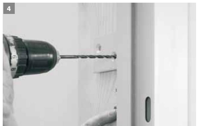
Durch Bohrung aller Dübelanker den Holztürstock bzw. Zarge anbohren.
